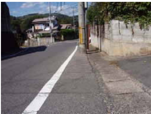
一般的な日本の電柱(倉敷市)
